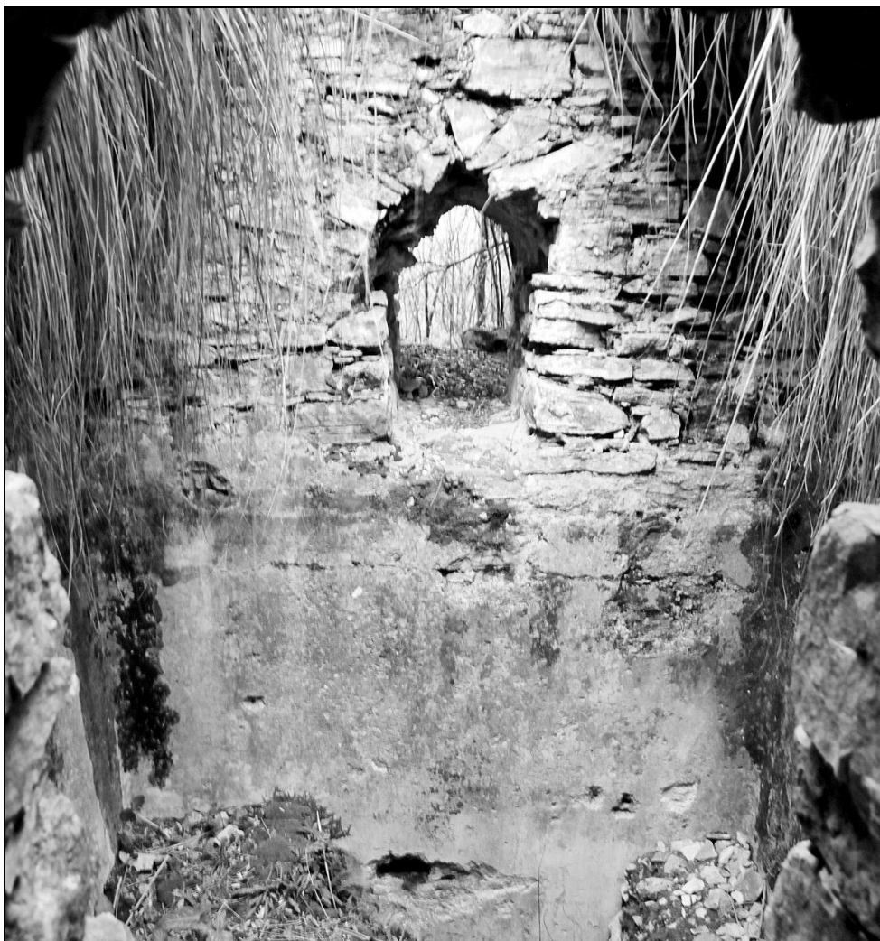
Foto. 3 – Buon Riparo, vista interna del tratto interrato dei resti dell'edificio a torre. L'edificio comprende una altezza fuori terra di ca 3,5 m ed altrettanti interrati. La struttura in muratura presenta, inserite nelle lunette della volta a crociera, due finestre a sesto acuto contrapposte. Il tratto di muratura sottostante la quota delle aperture risulta rivestita da intonaco signino che ne dichiara la destinazione d'uso come cisterna per l'accumulo delle acque meteoriche. Non sono stati individuate in zona sorgenti o altri impianti di immissione. L'esigua capacità di raccolta dell'impianto, legato al semplice percolamento delle acque meteoriche sulla struttura edilizia, non consentiva certo di distribuire l'acqua all'esterno dell'insediamento. Vasche di accumulo, destinate alla riserva idrica locale, sono comunque tipiche e caratterizzano tutti gli impianti a carattere militare del periodo medioevale
